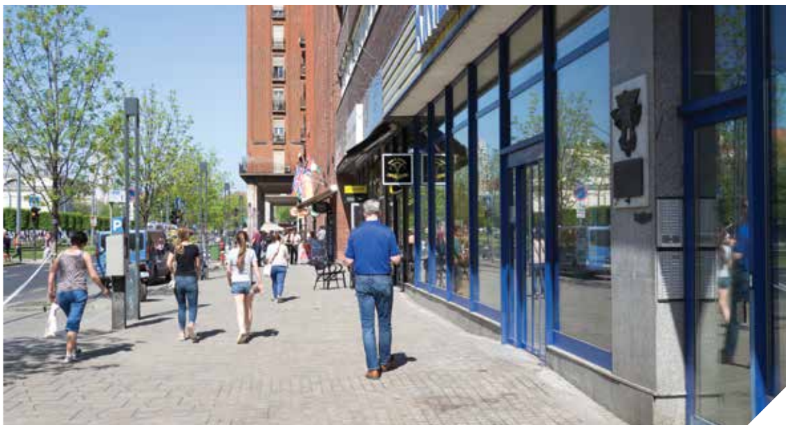
Bank bejárata a Károly körúton. A köztéri burkolat lejtése felveszi a bejárat előtti magasságkülönbséget, így az előlépcső megszüntethető.
