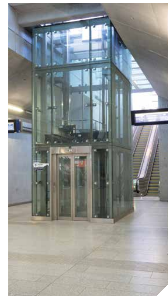
Az aluljáró szintről a felszínre, a vasúti peronra vezető függőleges közlekedő magokban egyenrangú útvonalként szolgál a felvonó és a mozgólépcső. A fényképen nem látható, szemközti oldali feljárt lépcsős kialakítású.
